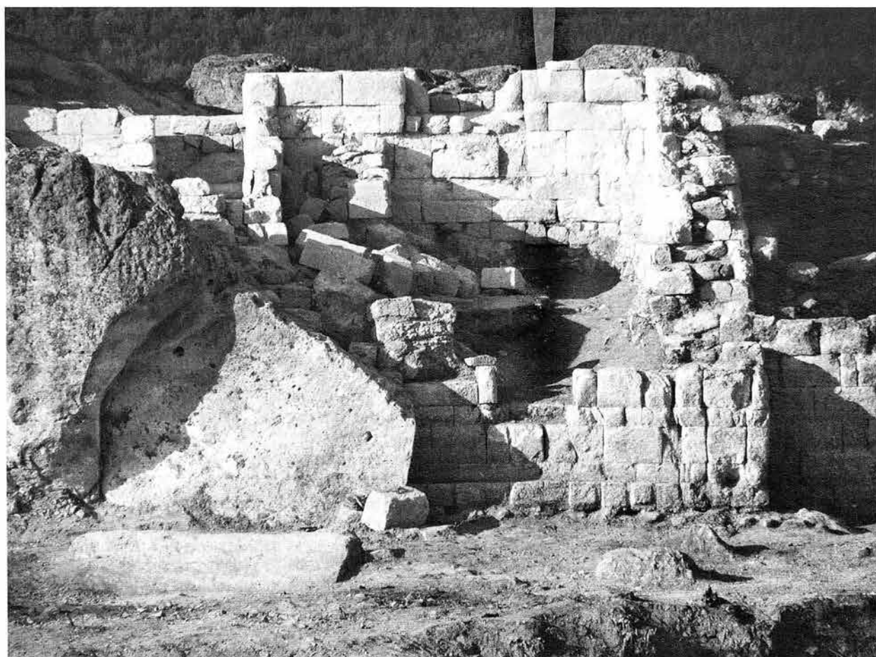
Обр. 2. Татул. Сграда № 1 от север Fig. 2. Tatul. Building No 1 (view from north)
