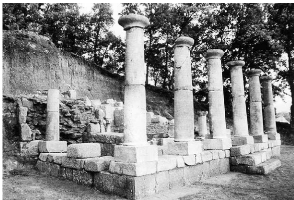
Обр. 7.2. Старосел, Пловдивско. Снимка на реставрираната колонада видяна от югоизток (по Китов 2008, обр. 289) Fig. 7.2. The tomb in the Horizont tumulus near Starosel, Plovdiv district. Photo of the restored colonnade from the southeast (after Kitov 2008, обр. 289)
