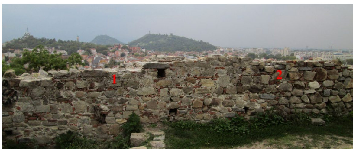
Fig. 20. Medieval upgrade of the western wall on Nebet Tepe, 13 th – 14 th c. View from the east Обр. 20. Средновековно надграждане на западната стена на Небет тене, XIII – XIV в. Поглед от изток
